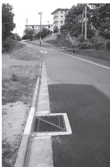
花見川小学校通用門近くの坂道・改修された排水口
