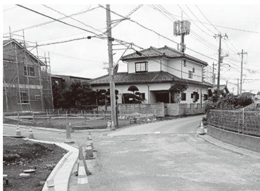
整備中の武石町10号線
